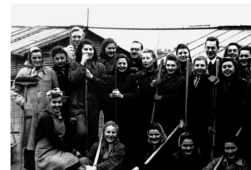
Luftschutzfrauen auf dem Dach der HV der Frankfurter Versicherungs-AG in Frankfurt am Main. (1943/44)
